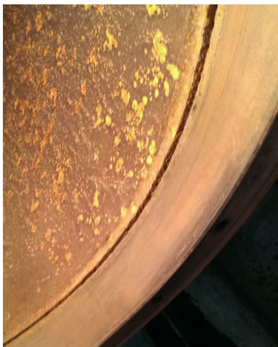
Рис. 4.3. Внутренняя поверхность прессового вала БДМ до ремонта
