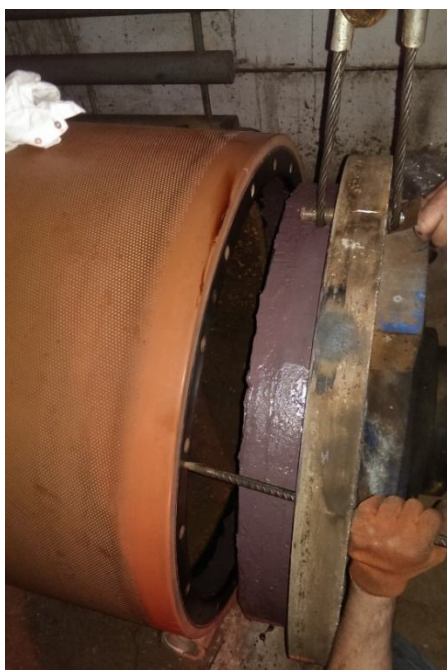
Рис. 4.11. Монтаж цапфы на вал
