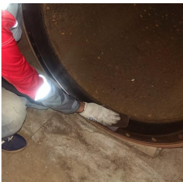
Рис. 4.5. Ручная зачистка поверхности вала
