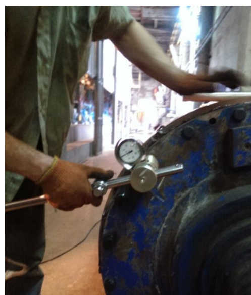
Рис. 4.15. Проверка затяжки динамометрическим ключом
