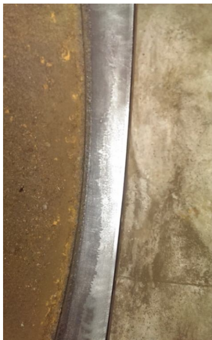
Рис. 4.7. Внутренняя поверхность вала после зачистки
