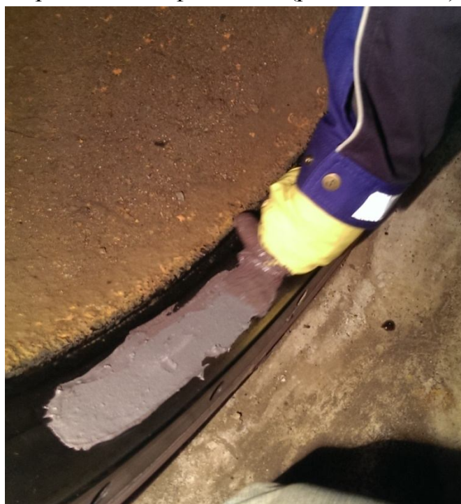
Рис. 4.12. Нанесение РКМ на вал (вспомогательный слой)
